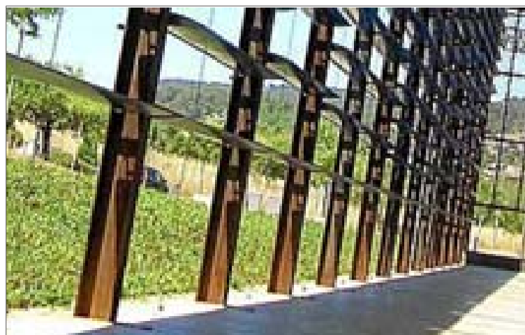
Parte baja de uno de los edificios del ParcBit.
